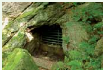
Fot. 69 Wnętrze sztolni zabezpieczone przed wejściem intruzów (BJ)
