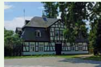
Fot. 201 Przykład budynku z muru pruskiego (Milicz) (BJ)
